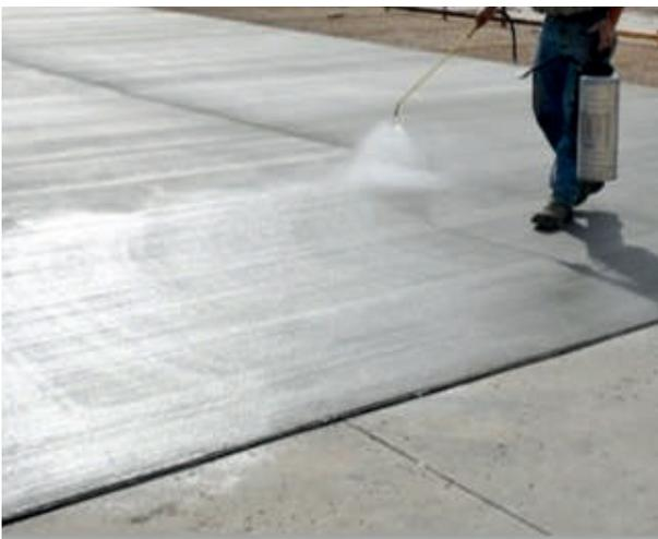
Los pavimentos de hormigón son los que deben soportar el alto tráfico, impactos y derrames de productos propios de la operación productiva dentro de una instalación industrial. Por lo anterior, tanto en su diseño como en su construcción, se debe procurar una correcta selección de los agentes que mejorarán su desempeño y prolongarán su vida útil.
